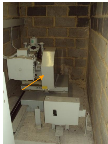
Photo 2 4 ème étage, machinerie
