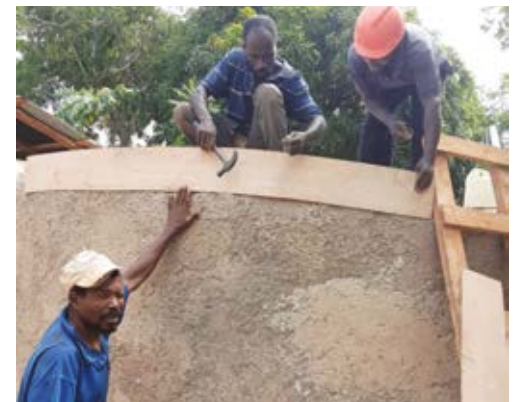
Laatste fase op de werf van de schooltank van Lafèvre. Deze regentank, die op het moment van de aardbeving in aanbouw was, werd slechts licht beschadigd. De afronding van de werkzaamheden was een prioriteit om de lokale bewoners toegang tot drinkwater te geven.
