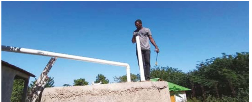
Een lid van het team van PAD installeert de goten voor de afvoer van de watertank van de gemeenschap Bernagousse. Het systeem werd beschadigd tijdens de aardbeving. Gelukkig liep de regentank weinig schade op.
