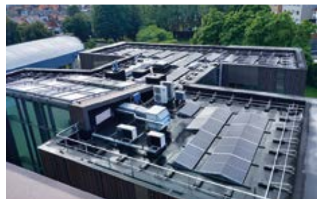
De plaatsing van fotovoltaïsche cellen (hier aan de crèche Aimé Dupont) behoort tot de belangrijke acties voor de schoolgebouwen.
