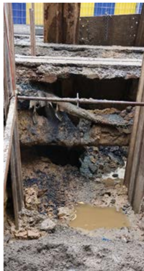
In de Victor Jacobslaan nabij het Sint-Antoonplein moest de weg gedurende een maand opengelegd worden voor gelijkaardige werkzaamheden. Eind februari eindigden de werkzaamheden.
