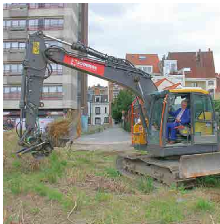
De burgemeester en de OCMW-voorzitter gaven het officiële startschot van de bouw van het Jongerenpaviljoen op 2 september.
