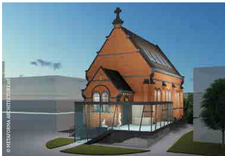
De hoofdingang van de kapel wordt verbouwd: er komt een glazen gang naar de foyerruimte.
