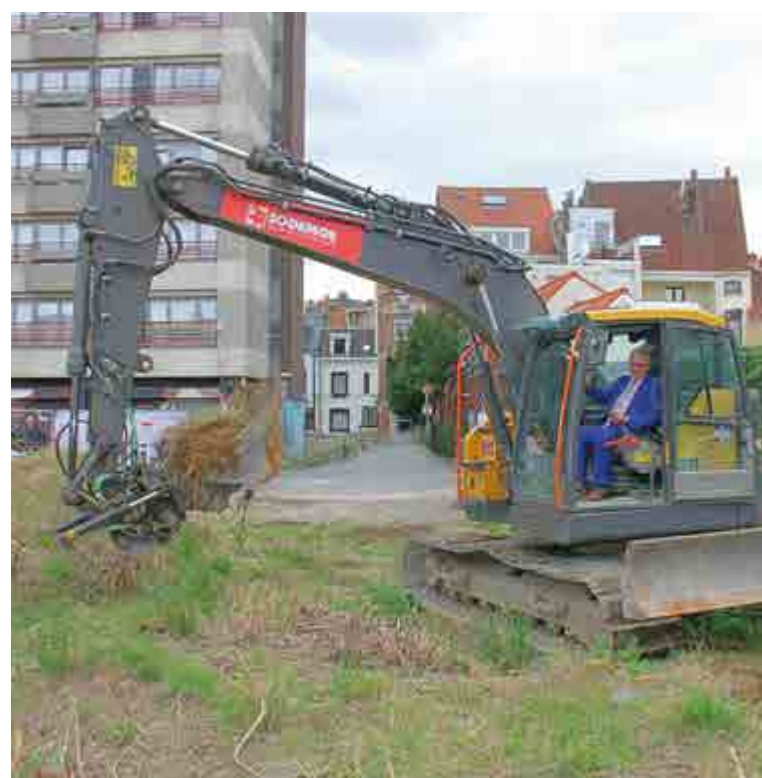
Le bourgmestre et le président du CPAS ont officiellement lancé le chantier du Pavillon des jeunes le 2 septembre dernier.
